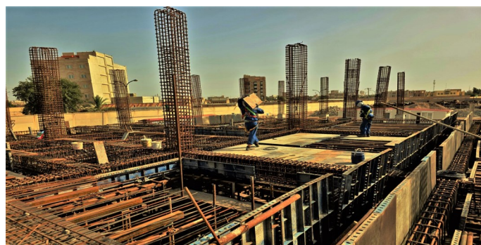
ساختمان پست کفیشه
