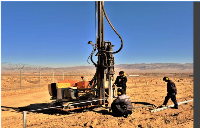
ماشین پایه کوب در کارگاه بهاباد
